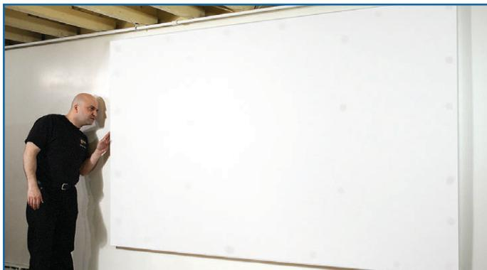
*Проверка грунтованной поверхности на наличие неровностей перед нанесением Screen Goo.*
